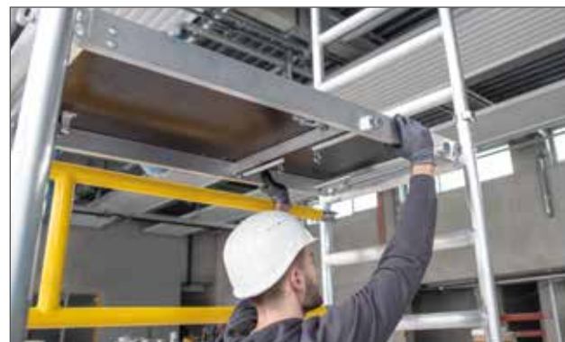
Stabile Plattformen mit Schnellverschlüssen
