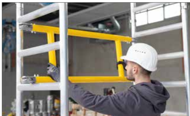
Pulverbeschichtete Geländerrahmen als Querstreben
