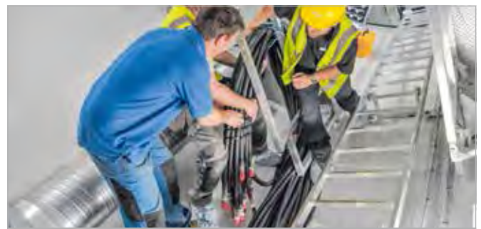
Supervising beim Einbau
