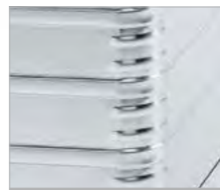
Umlaufende Sicken und Ecksicken
