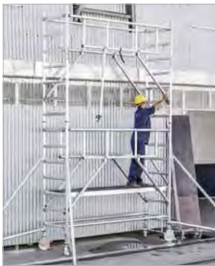
2. Geländer an Sprossen befestigen
