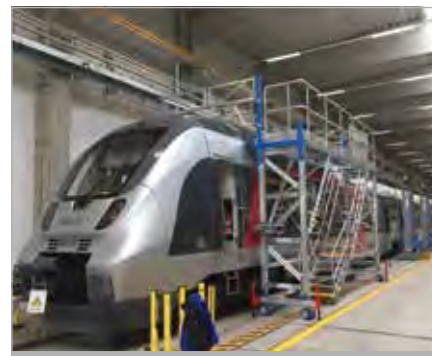
Einseitige Dacharbeitsbühne mit ausklappbarem Geländerkäfig zur Wartung eines Zugs der Abellio GmbH
