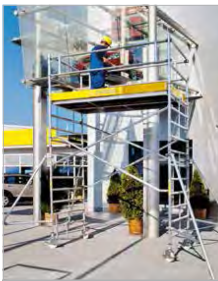
Strebenfreie Fahrgerüste gibt es in zwei Breiten (0,75 m und 1,35 m) und sie können bis 10,40 m aufgebaut werden. Die Strebenfreiheit beträgt bis 1,90 m (mittig).
