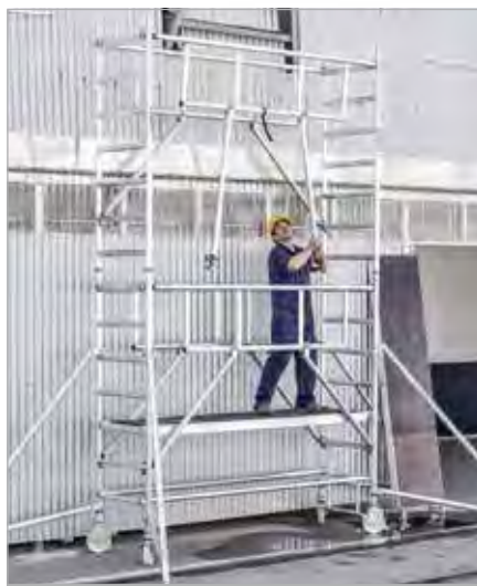
1. Vorlaufendes Geländer einsetzen
