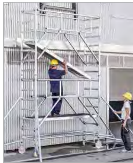
3. Plattform von gesicherter Position einhängen
