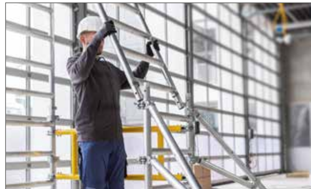
Intuitive Steckverbindungen mit Federclips
