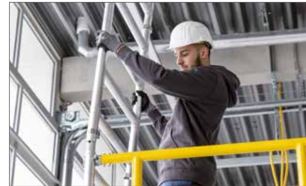
Weitere Aufsteckrahmen einsetzen
