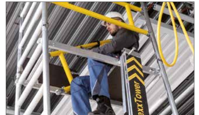
Obere Geländer und Bordbretter montieren
