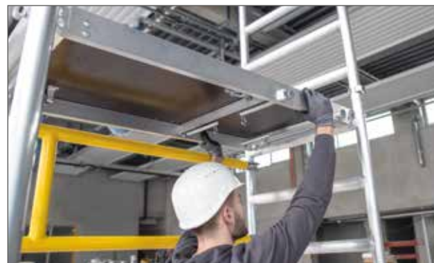
Stabile Plattformen mit Schnellverschlüssen
