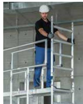
Gesichert durch das „vorlaufende Geländer“, kann die Plattform nun gefahrlos betreten und der weitere Gerüstaufbau fortgesetzt werden. Das Montagesicherungsgeländer wird für folgende Plattformen wieder „vorlaufend“ eingesteckt.
